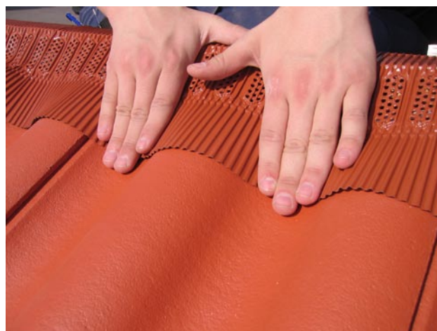
Montering steg 4. Pressa från toppen på takpannan ner mot vågdalen. Var noga med att kanten sluter till ordentligt, för en optimal tätning mot takpannorna.
