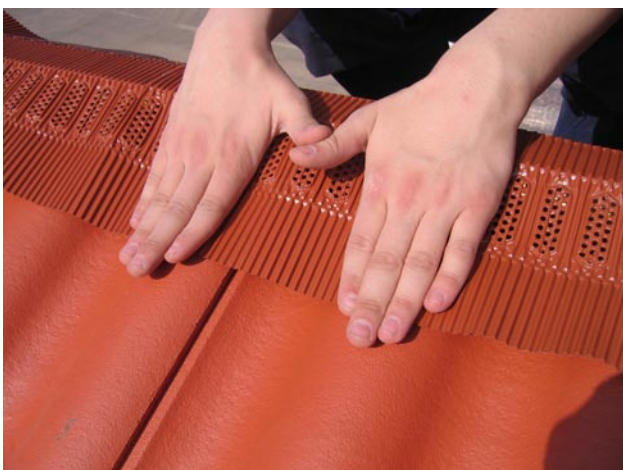
Montering steg 3. Vik ner kanten, forma rullen mot takpannornas toppar. Var noga med att luftningsdelen på rullen ej hamnar direkt mot nockplankan. Luften skall gå fritt från underkant av takpanna tills den går ut under nockpannan.
